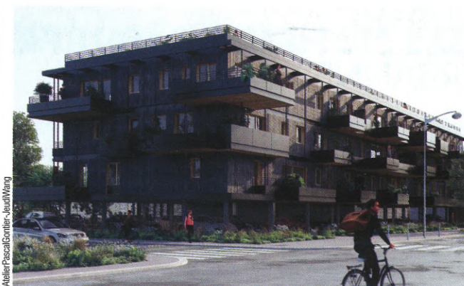
Logements en FOB coconçue, à Floirac, Atelier Pascal Gontier, arch.
