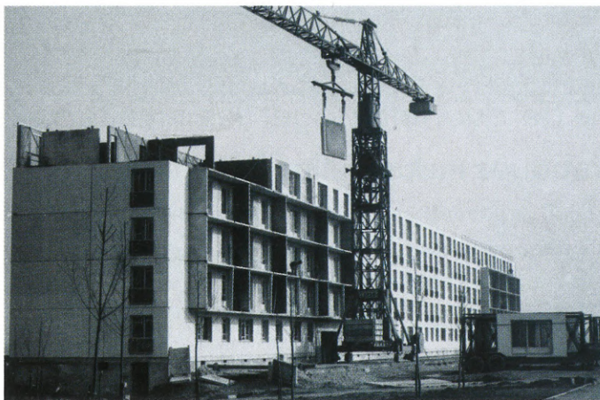
Procédé de préfabrication industrielle Coignet, en 1967.
